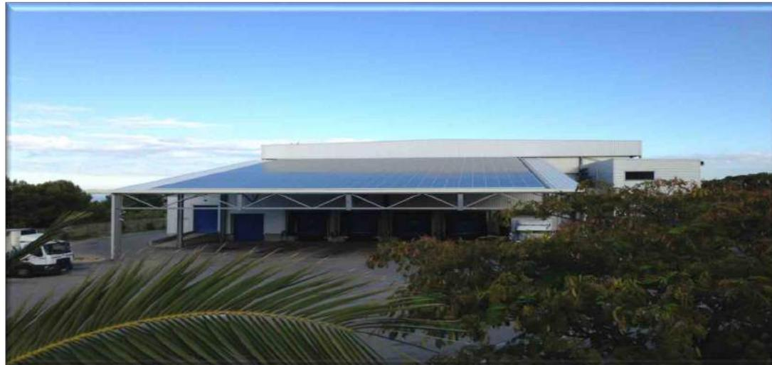
Une surface de 1000 M<sup>2</sup> de panneaux photovoltaïques a été installée sur le préau qui produit de l'électricité et qui protège nos véhicules du soleil et de la pluie lors des phases de chargement et de déchargement
