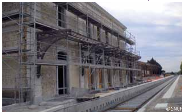
Les quais de la future halte de la Barasse, située entre Saint-Marcel et la Penne/Huveaune
